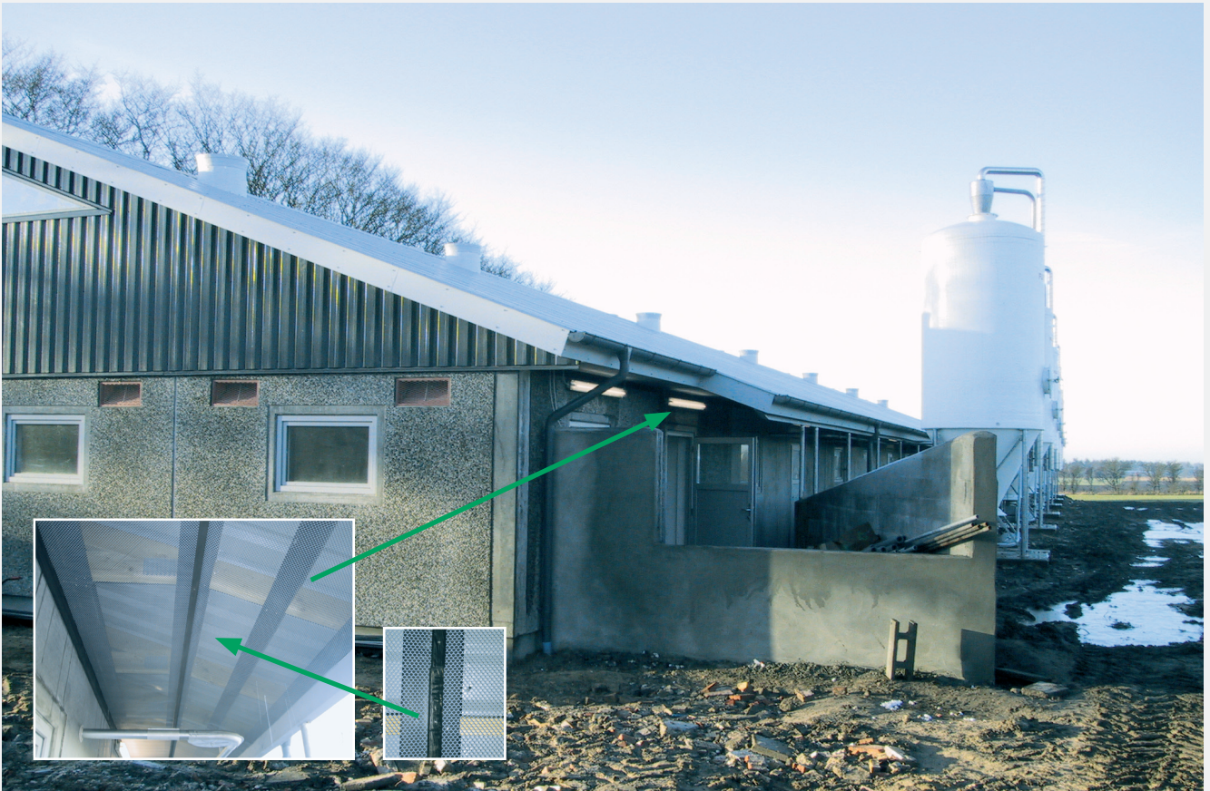
Vindbrydende net type EXPO1211 monteret i udhæng på staldbygning.
