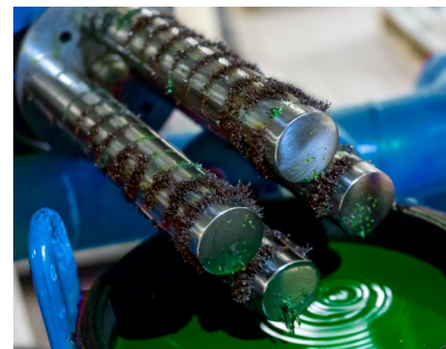
Svævemagnetit i kredsløbet kan effektivt afhjælpes med delstrømsfiltrering gennem et posefilter med magnetindsats.
