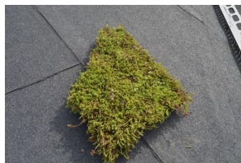
8. Modulerne tilskæres efter behov fx med stor isoleringskniv. Der skæres mod skærefast underlag. Skær aldrig direkte mod membranen.
