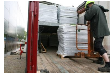
3. Ved modtagelse af varer/ moduler på byggepladsen, skal disse kontrolleres og godkendes. Svøbet om pallerne fjernes straks efter afsætning på taget.
