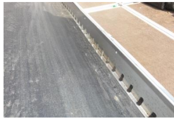
2. Kontroller tagmembranen, kantafslutninger, afløb, tagfodsdetaljer m.m.
