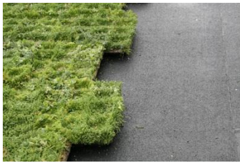
5. Modulerne placeres forbandt, kant mod kant til alle sider. Tjek for fuld jord til jord kontakt, efterfyld hvis nødvendigt med vækstmedie.
