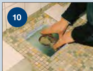
Flangen trykkes ned i tætningsmassen, så det flyder ud omkring flangen, både over og under. Dette er en meget vigtig tætning. Bør evt. skrues fast.
