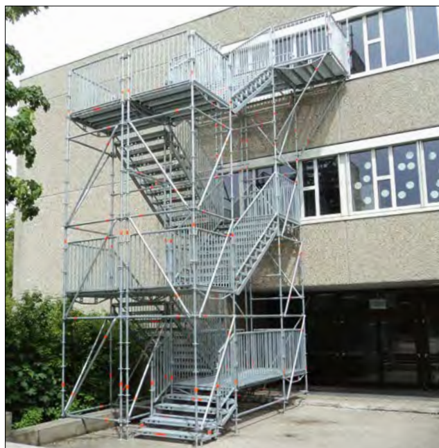
Tilpasning af indgangs- og udgangsniveauer i bunden eller toppen af trappen ved hjælp af udligningstrapper af forskellig højde.
