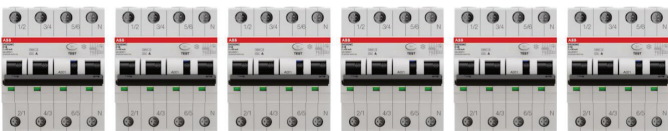
K3-3 2xKOMBI 4P 16A-C + 2xKOMBI 4P 13A-C + 2xKOMBI 4P 10 A-C
