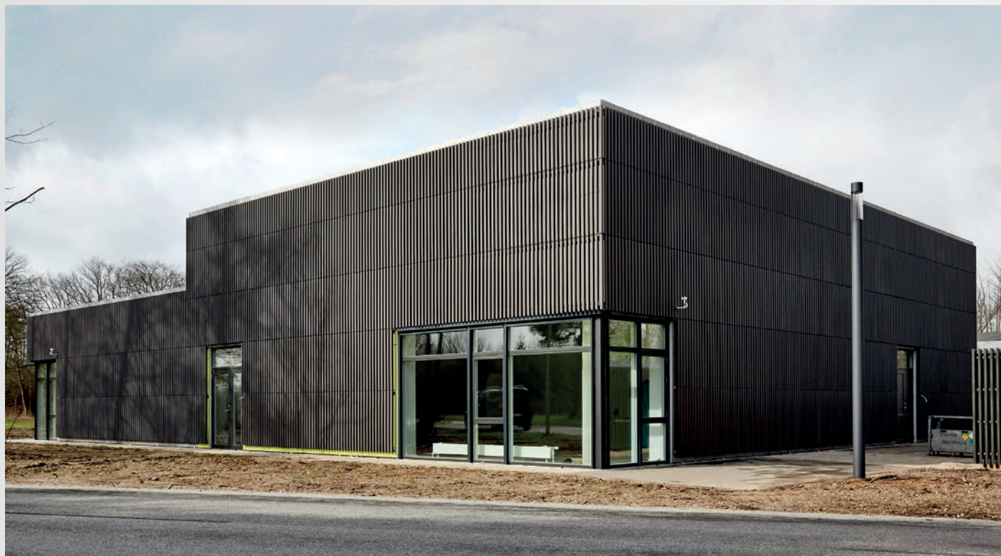
tempio®[projects] Flyvestation Skrydstrup Bygningen, Denmark.
