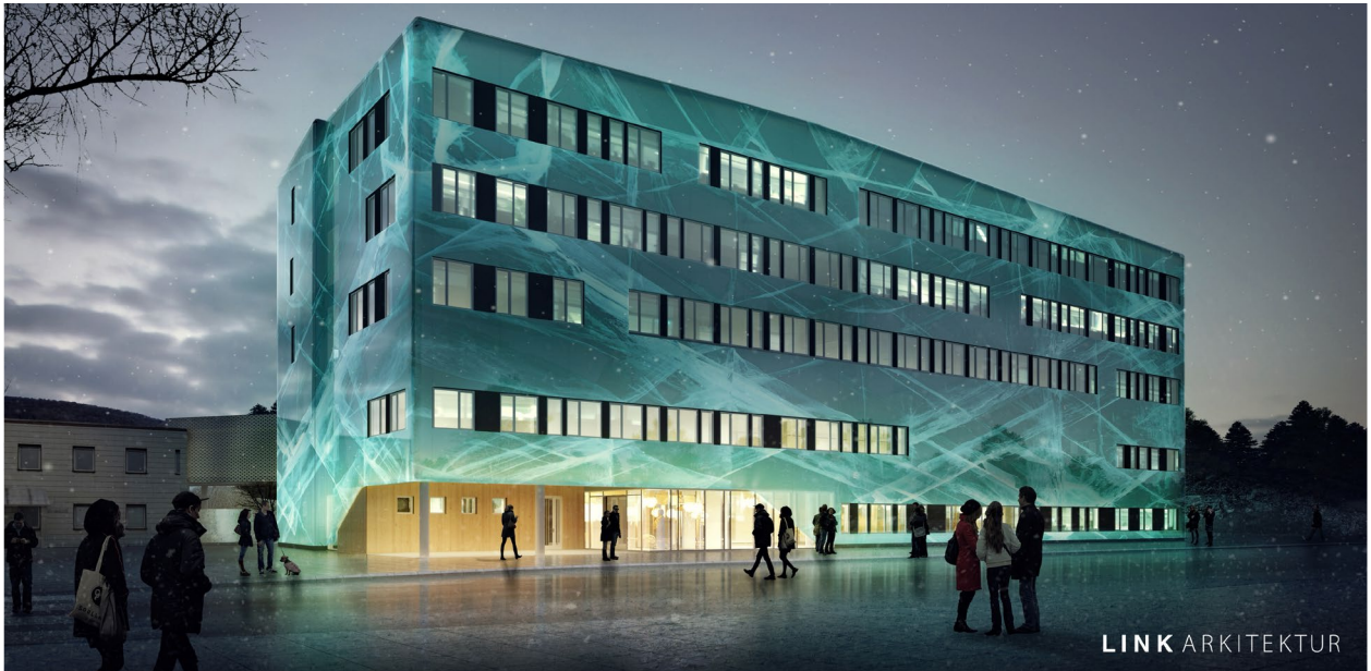
UNN PET medical center, Tromsø, Norge. Architect: LINK arkitektur.
