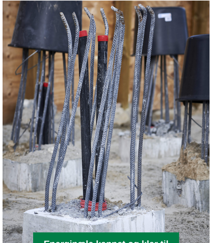
Energipæle kappet og klar til rørsammenføring
