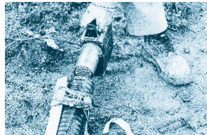
3. Brug varmluft eller varmt vand til at opvarme medierøret, lad det køle af og færdig.
