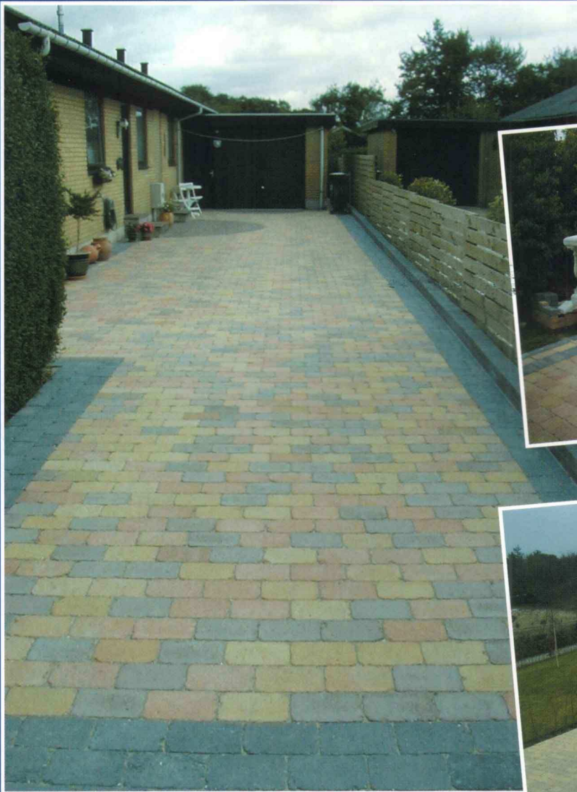
Indkørsel i gulmix Herregårdssten med brune sten iblandet sort rulleskift. Samt 2 brunmix halvcirkler i Herregårdscirkelsten.
