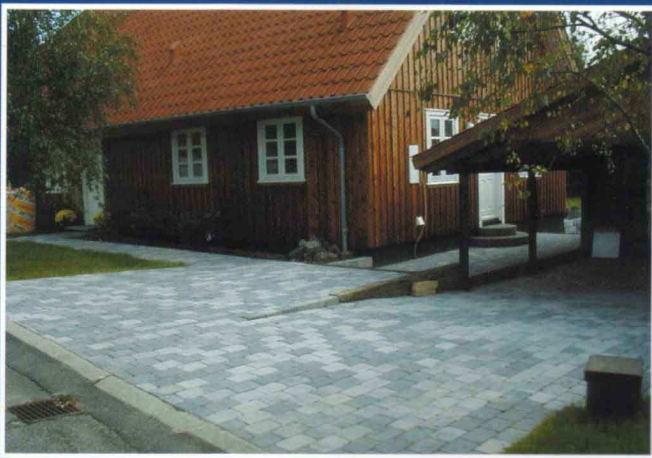
Indkørsel i gråmix Herregårdssten m/presset kant.
