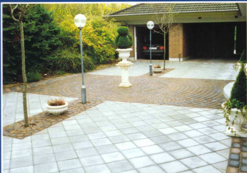
Grå 30x30x5 fliser lagt diagonalt. Brunmix Herregårdscirkelsten i midten.
