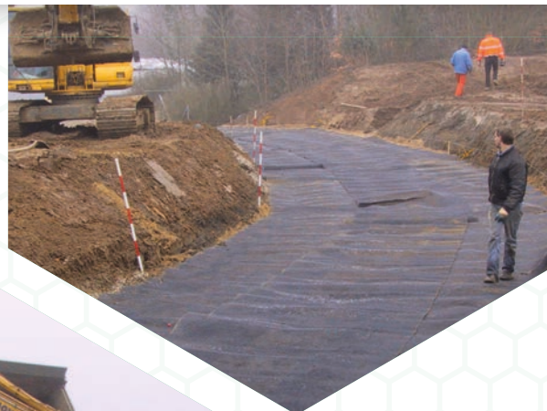
Vejarmeringsprojekt samt parkeringsplads med anvendelse af EXPO-NET armeringsnet
