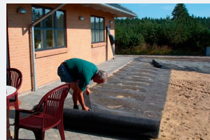
Nettet lægges ud på det etablerede underlag
