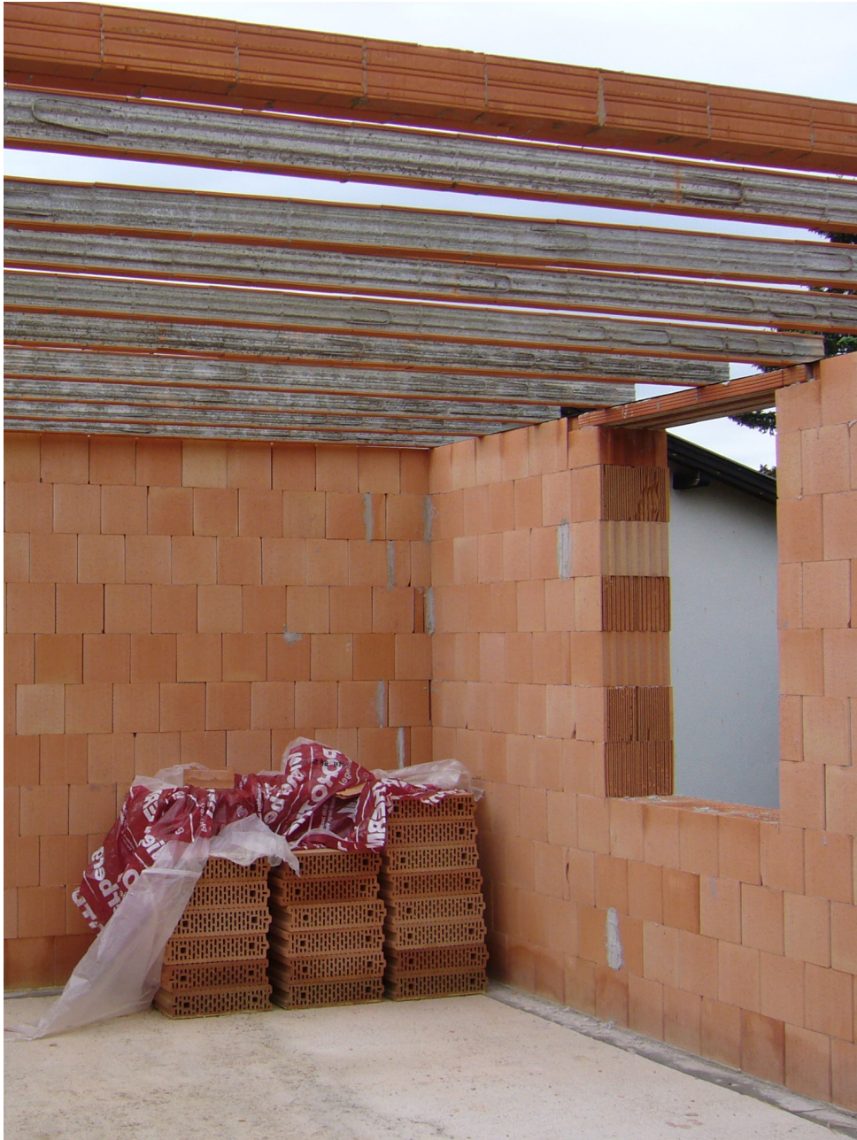
Byggeplads hvor teglblokke bruges til opbygning af ydervægge og indervægge. Præfabrikerede bjælker i loft til udlægning af dækkelementer i tegl Præfabrikeret overligger ved vinduesåbning. Foto Nini Leimand
