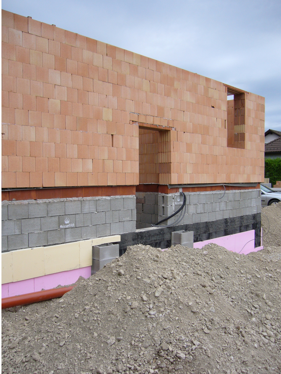
Byggeplads med enfamiliehus i Østrig, hvor teglblocke bruges til opbygning af ydervægge Foto Nini Leimand
